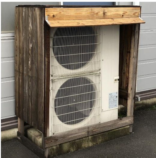
廃材を利用した室外機カバー
