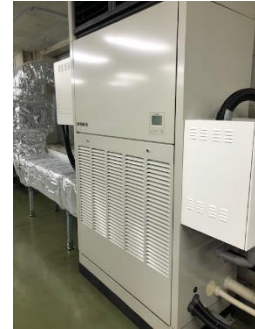
高効率空調機導入
