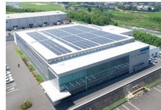
自家消費太陽光発電(本社工場)
