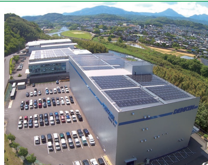
自家消費太陽光発電(本社第二工場) 本社第二工場に太陽光発電システム(パネル出力295kW)を設置しました。
