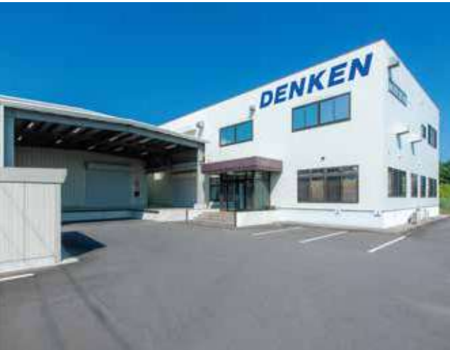
南杵築工場 電位・温熱治療器の製造はじめ、 その他製品の製造を行っています。
